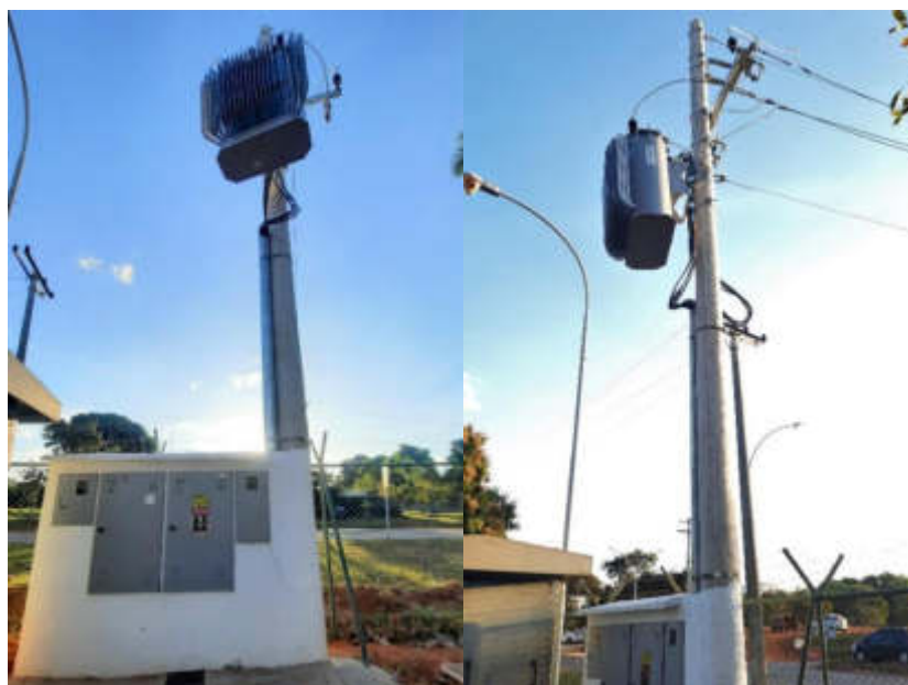
Figura 5 – Ramal de entrada de energia elétrica (subestação aérea) já existente.
