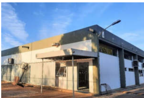
Figura 1 – Vista lateral da edificação na qual será construída a usina solar fotovoltaica.
