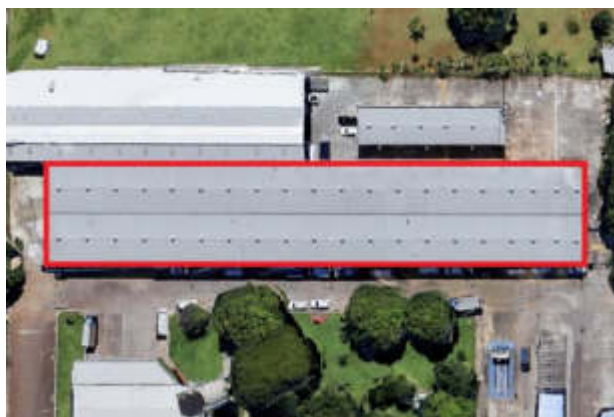
Figura 2 – Vista superior da edificação na qual será construída a usina solar fotovoltaica.
