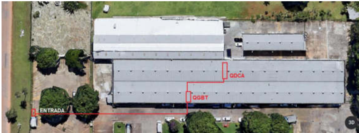
Figura 6 – Localização dos quadros elétricos (edificação e usina).
