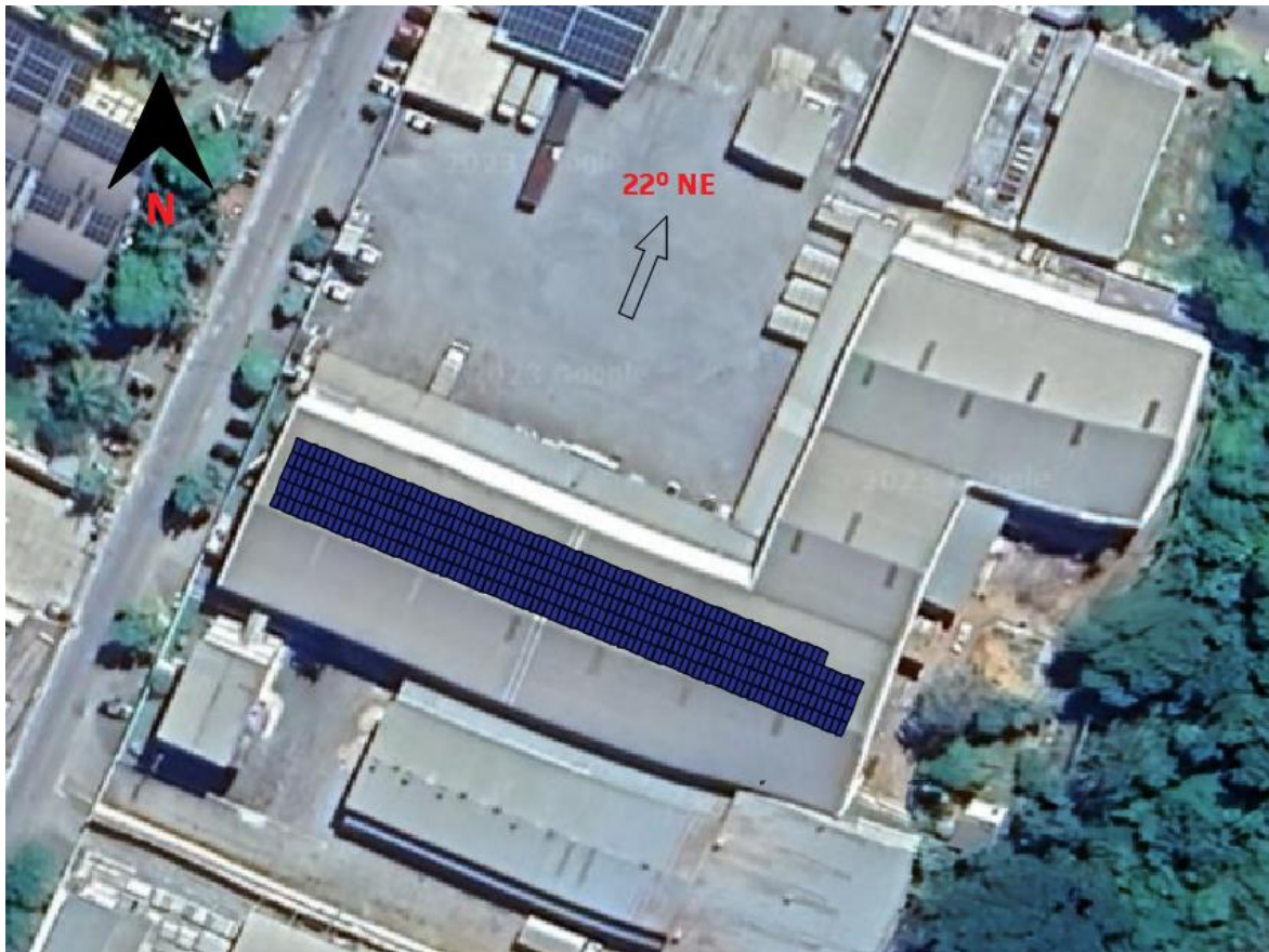
Figura 2: Disposição dos módulos fotovoltaicos no telhado.
