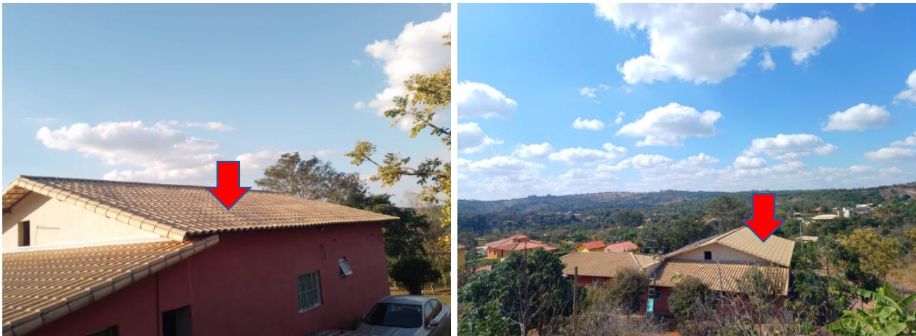
Figura 8: Local de instalação dos módulos fotovoltaicos.
