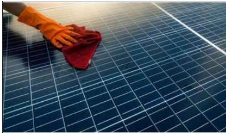
Figura 10: Representação de Limpeza do Módulo.
