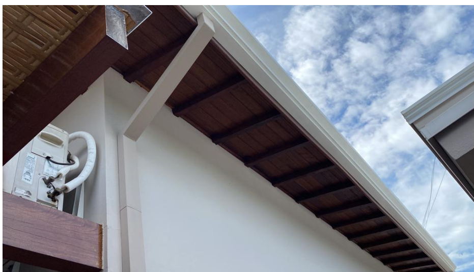
Figura 10: Estrutura do telhado.
