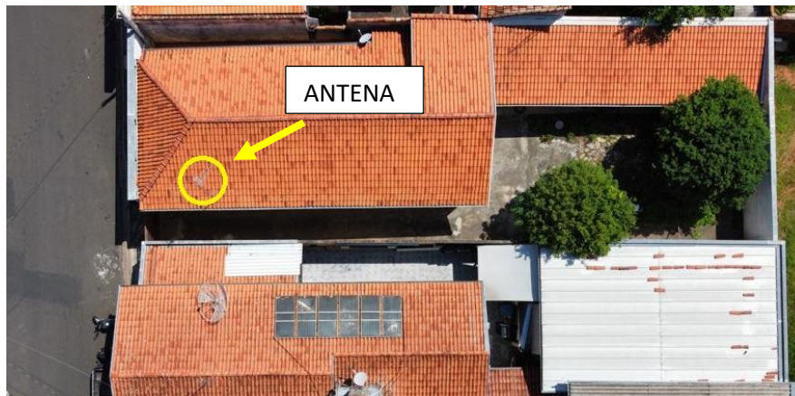
Figura 3: Imagem do telhado da residência com detalhe da presença de uma antena.
