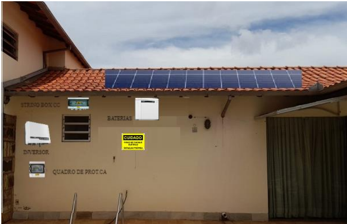
Figura 2: Disposição dos equipamentos do SFV.
