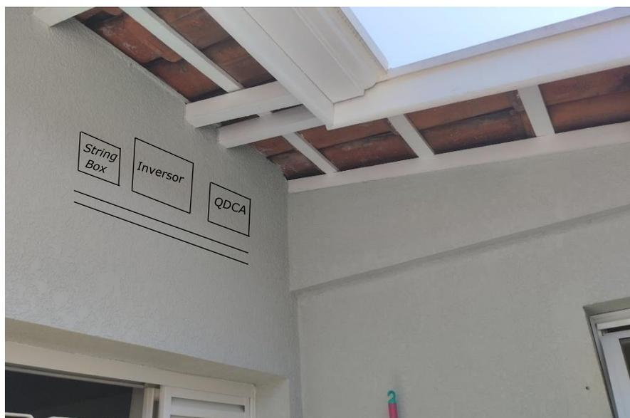
Figura 5 - Local de Instalação do Inversor com a projeção dos aparelhos instalados
