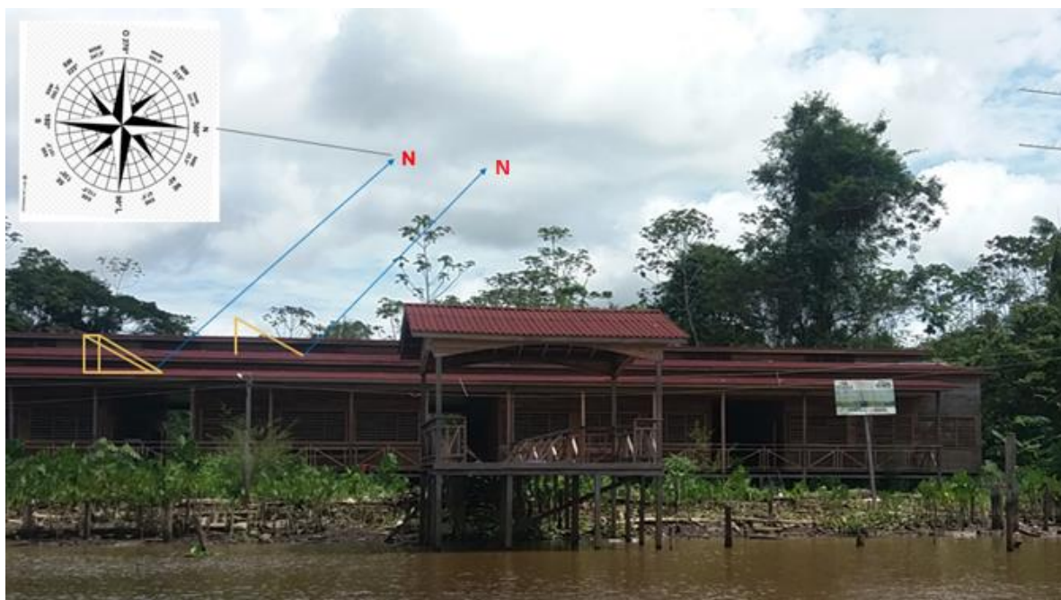
Figura 2: Local da instalação dos módulos fotovoltaicos e possíveis pontos de sombreamentos. Fonte: Arquivo do autor.
