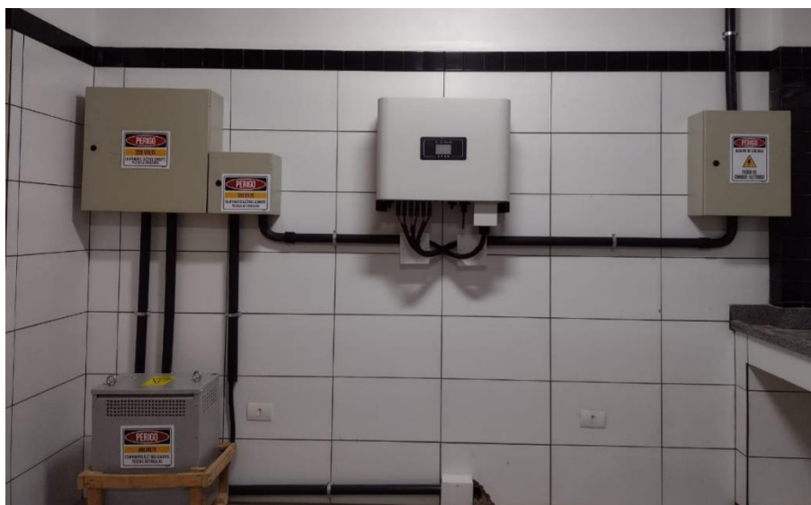
Figura 12: Instalação do inversor fotovoltaico e o sistema de proteção.
