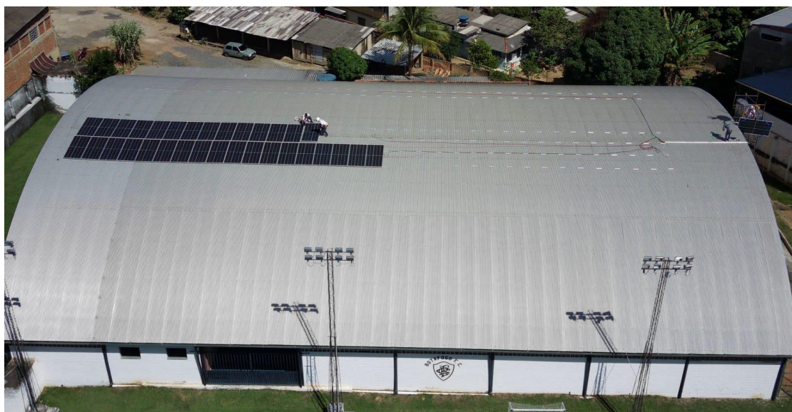
Figura 11: Processo de instalação dos módulos fotovoltaicos da usina.
