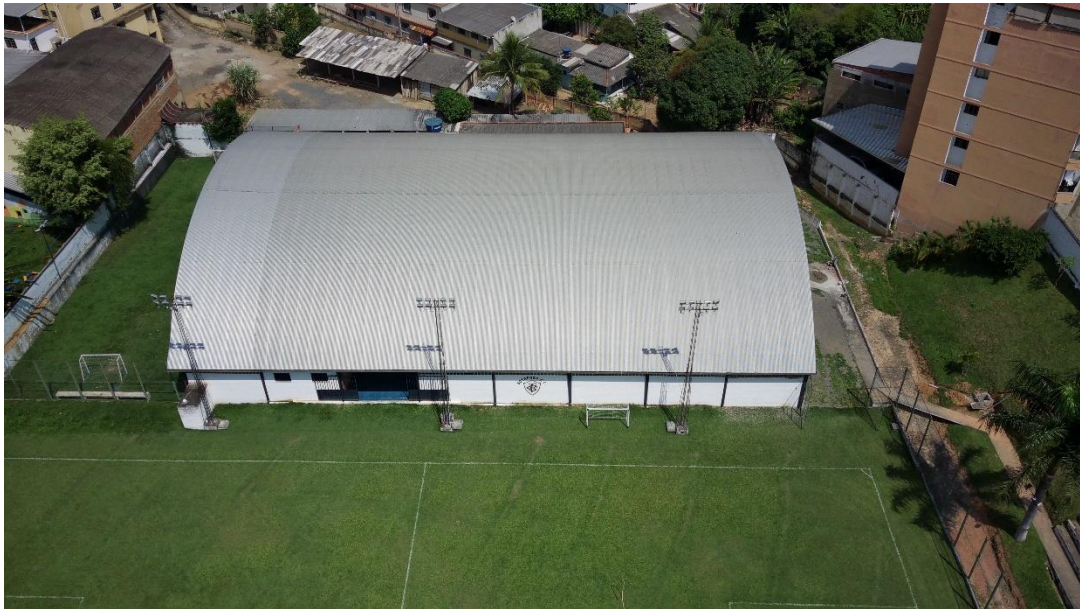
Figura 4: Telhado em que será realizado a instalação dos módulos fotovoltaicos.
