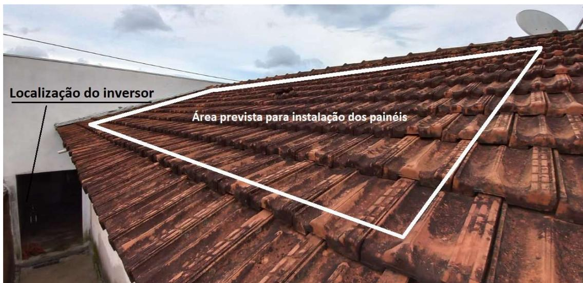
Figura 2: Face norte do telhado, área prevista para instalação dos módulos.
