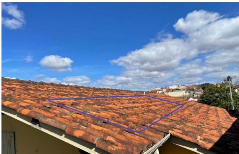
Figura 6 - Local de instalação dos módulos fotovoltaicos.
