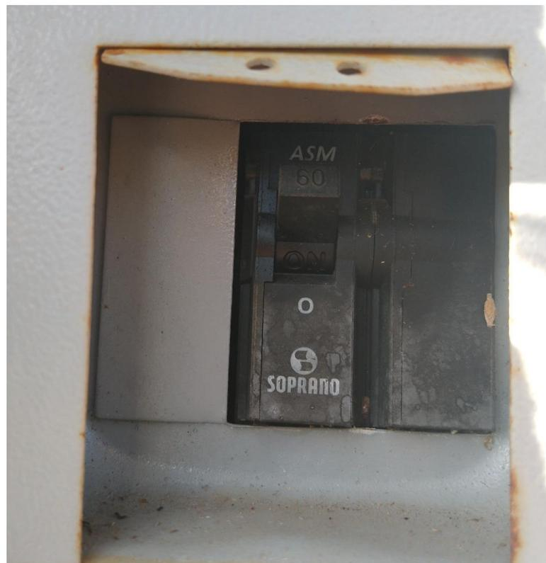
Figura 3: Disjuntor de 60 A - Medidor de energia.
