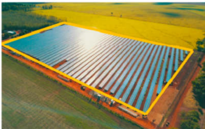
Figura 16: Exemplo do eletrodo de aterramento dos módulos fotovoltaicos. [10]
