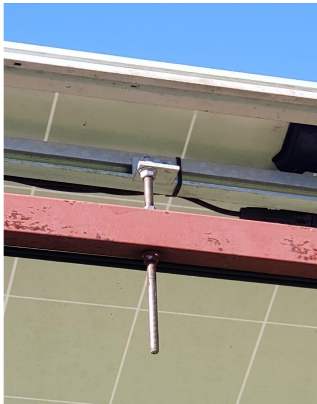
Figura 19 – Fixação de perfis trilhos de alumínio sobre perfis metálicos
