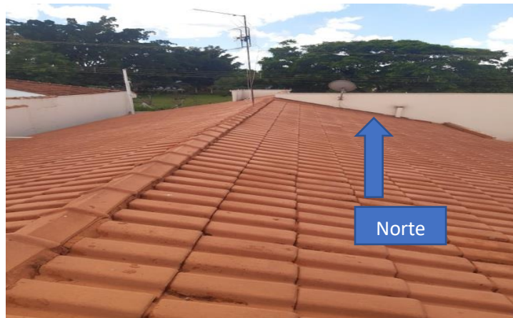
Figura 10: Porção lateral do telhado.
