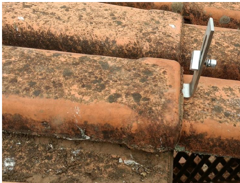
Figura 22: Detalhe da instalação em telhado colonial. Fonte: [6].
