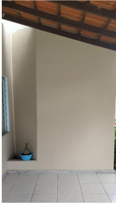
Figura 8: Local de instalação do inversor.
