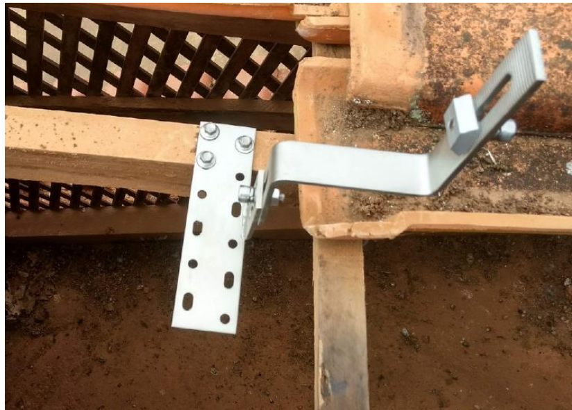
Figura 21: Estrutura de fixação para telhados do tipo colonial. Fonte: [6].
