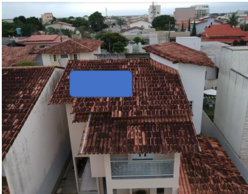
Figura 9: Local de instalação dos módulos fotovoltaicos.
