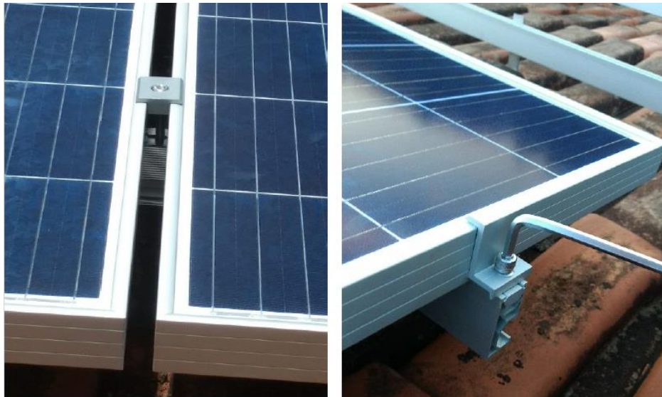
Figura 19: Grampos para fixar os MFV aos trilhos. Fonte: [6].
