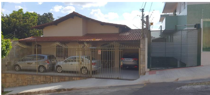
Figura 1: Vista Frontal do Local da Instalação.
