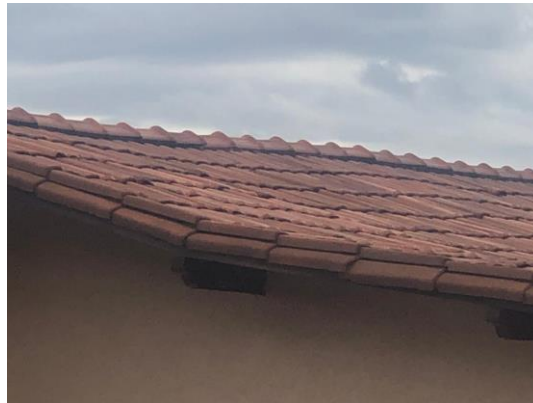
Figura 8: Telhado colonial da residência onde o sistema FV vai ser instalado.
