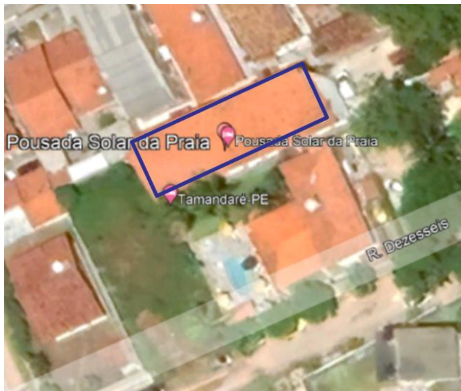
Figura 13: Local de instalação dos módulos fotovoltaicos da UF 01.
