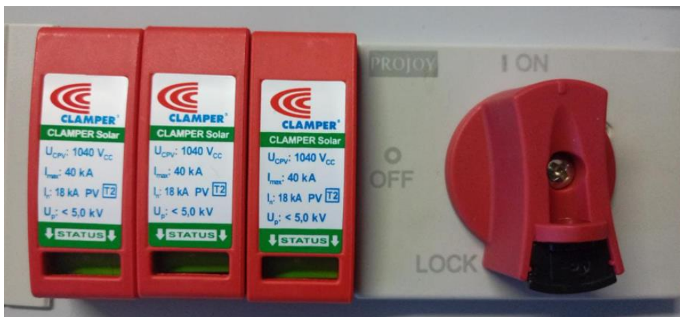
Figura 22: Chave seccionador e DPS CC
