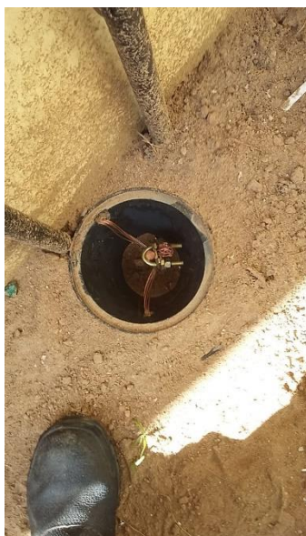
Figura 25: Conexão do aterramento na haste, com conector GTDU. Na caixa de inspeção.
