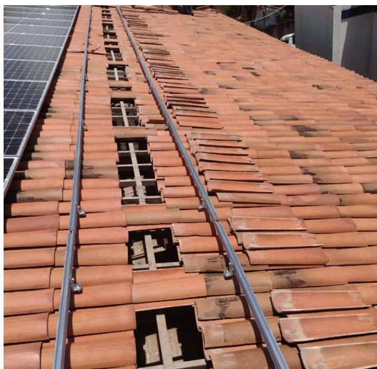
Figura 30: Trilhos e parafusos prisioneiros fixados no telhado do projeto
