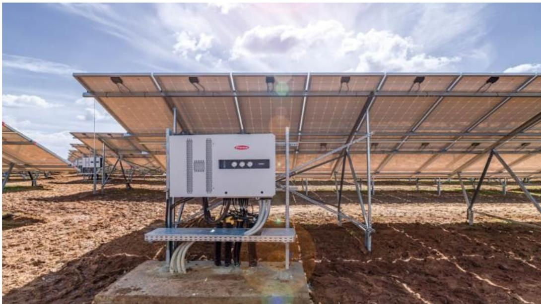
Figura 49: Detalhe da instalação do inversor junto aos módulos.
