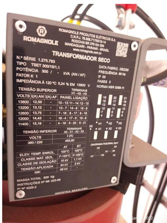
Figura 19: Trafo elevador a seco 300 kVA.
