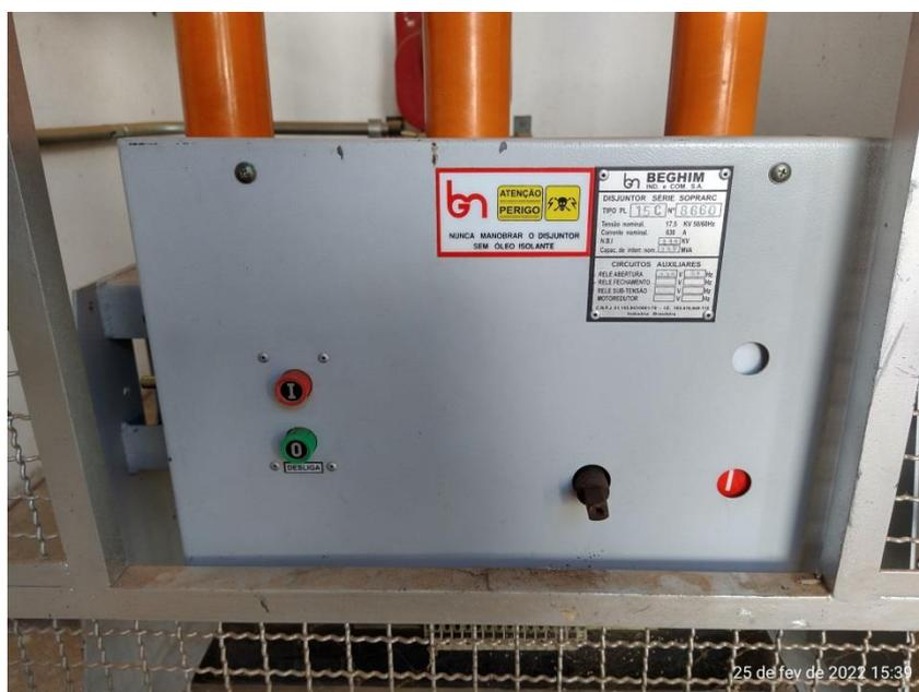
Figura 50: Detalhe do disjuntor da subestação de entrada.
