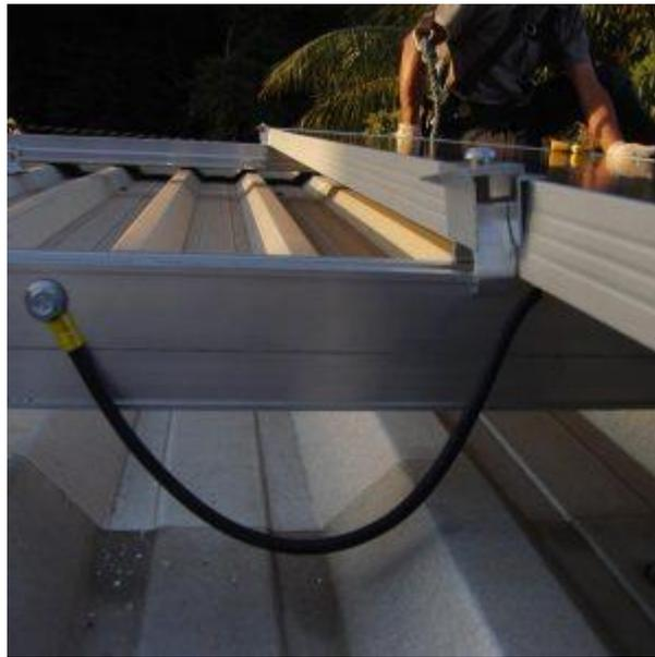
Figura 27: Detalhe da conexão do cabo terra do módulo ao trilho (figura ilustrativa).
