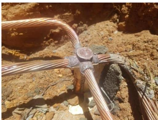
Figura 39: Haste conectada ao cabo.
