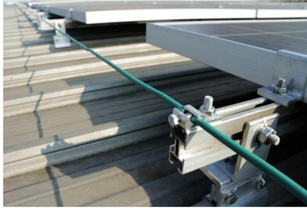
Figura 26: Detalhe do cabo terra utilizado para o aterramento (figura ilustrativa).
