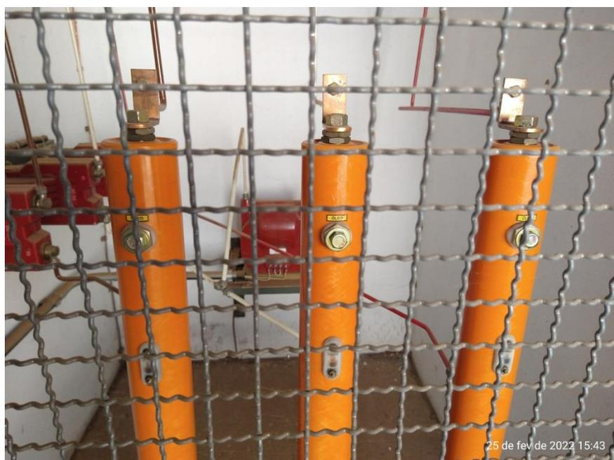
Figura 67: Detalhe do disjuntor PVO.
