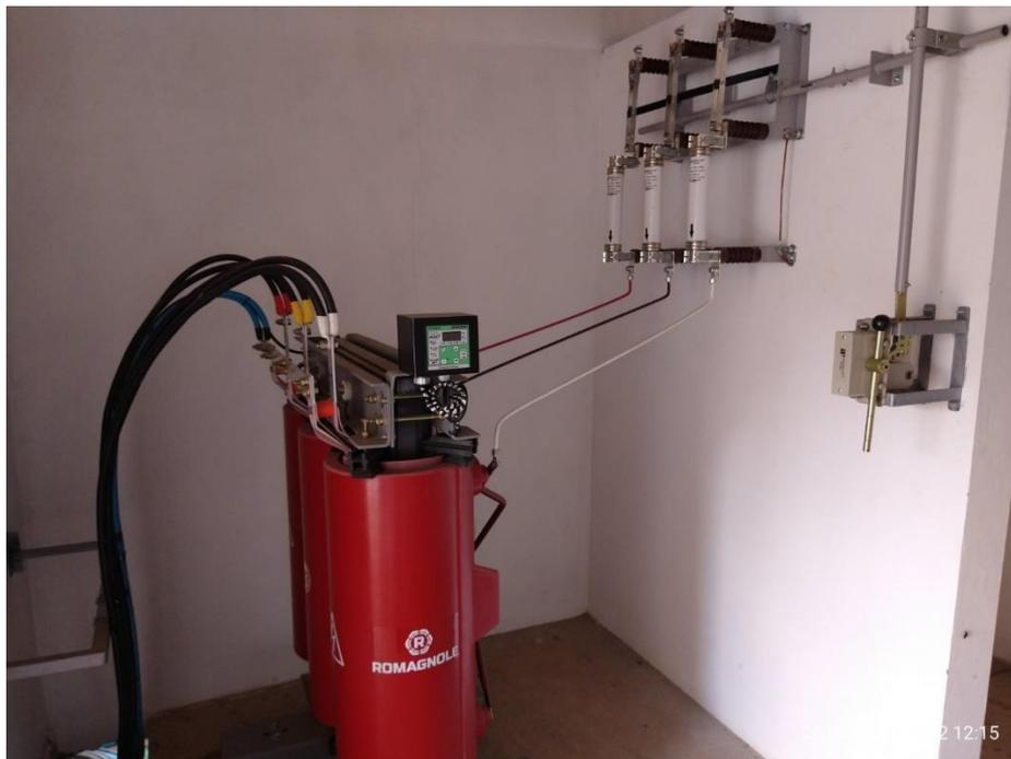
Figura 73: Transformador a seco, base fusível e seccionadora.
