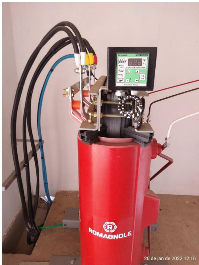
Figura 74: Transformador a seco.
