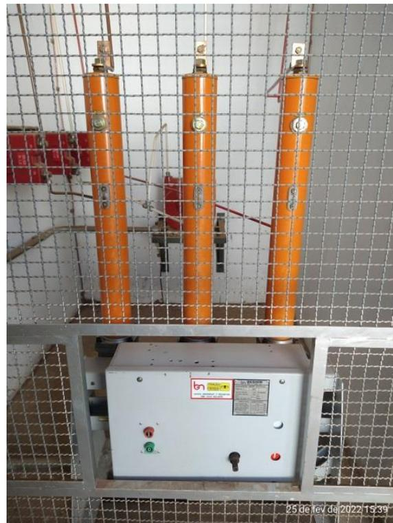
Figura 30: Disjuntor MT PVO BEGHIM existente.
