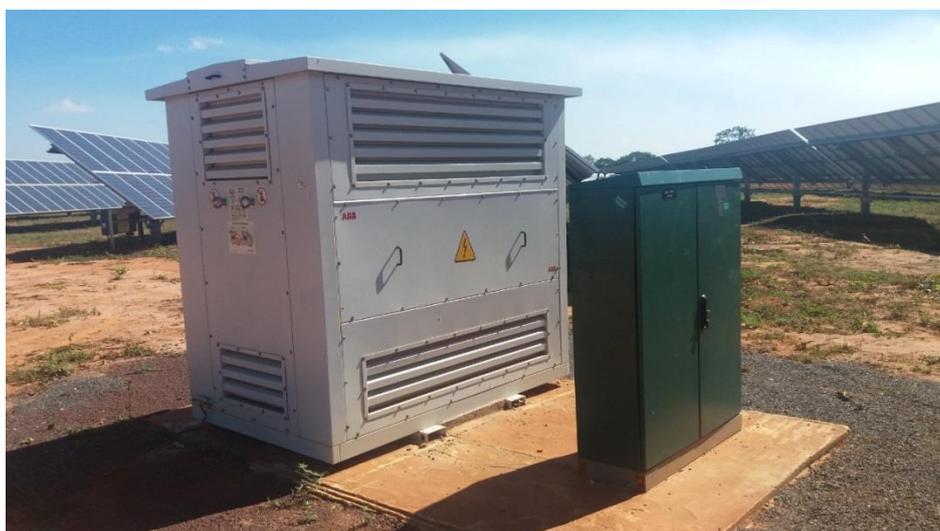
Figura 20: Cabines abrigando os disjuntores, barramento e transformador a seco.
