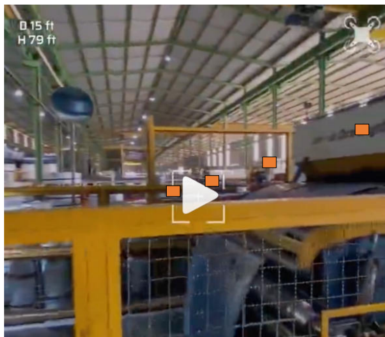
Figura 20: Local de instalação dos inversores fotovoltaicos.
