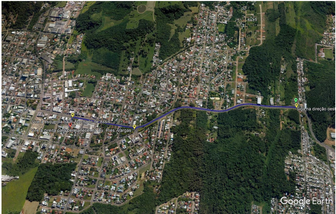
Figura 13: Trecho da rede de MT entre a subestação Estância Velha e a Cabine Primária.
