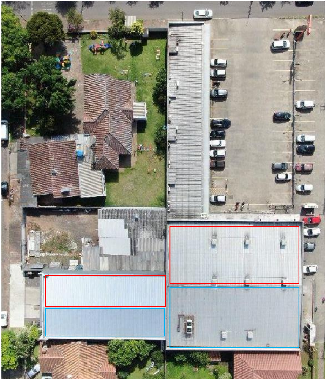
Figura 3: Imagem aérea do local de instalação da usina FV.
