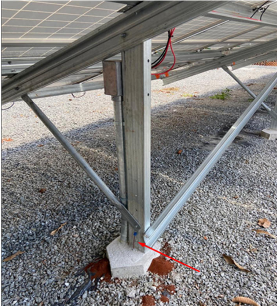
Figura 12: Condutor de cobre Nú – Aterramento da Usina
