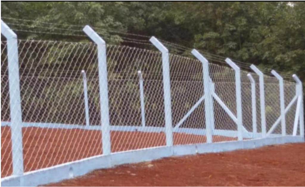
Figura 14: Cerca em alambrado
