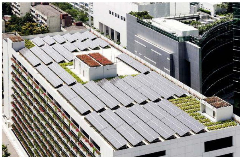
Figura 1 - Prédio com aproveitamento do telhado para geração de energia solar fotovoltaica. (REN21, 2016)
