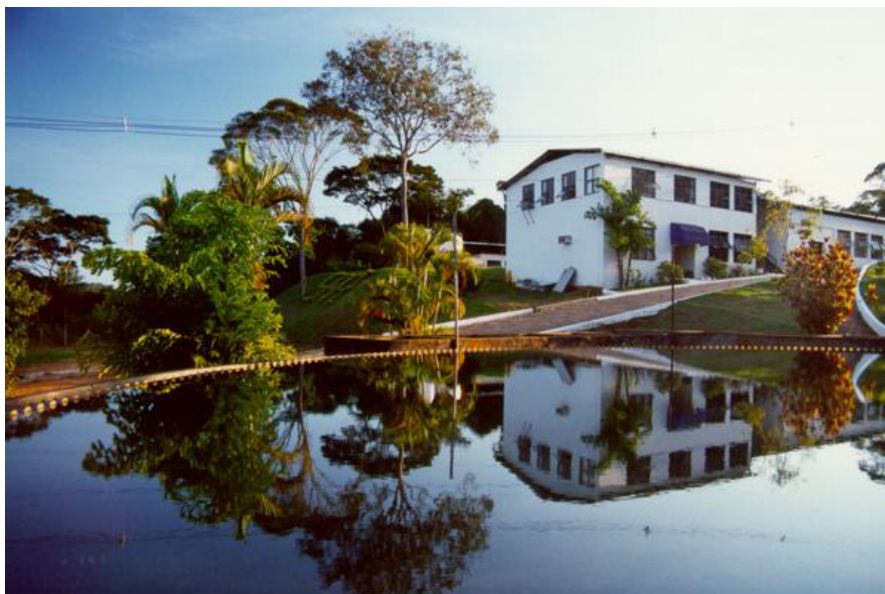
Figura 6 - Tanque de decantação na ETA 1. (SAAE, 2016)
