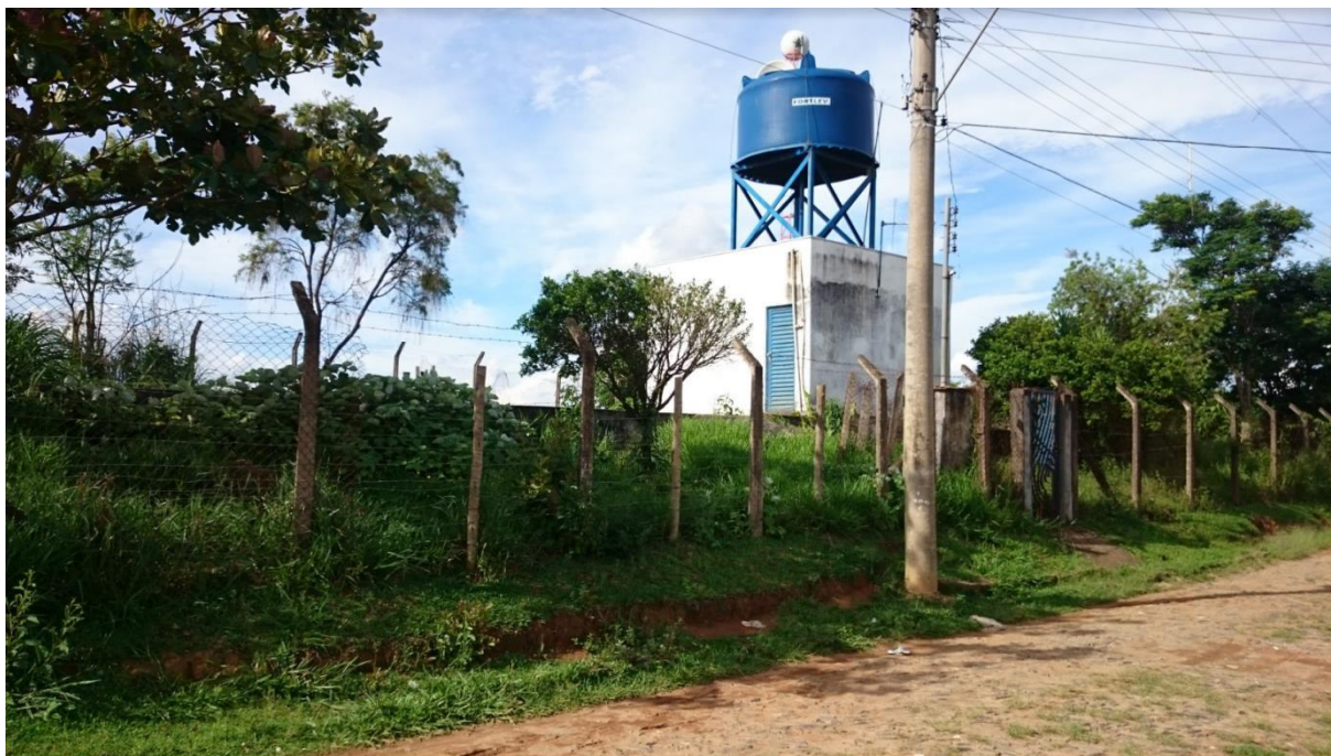
Figura 26 - Reservatório da Farinheira
