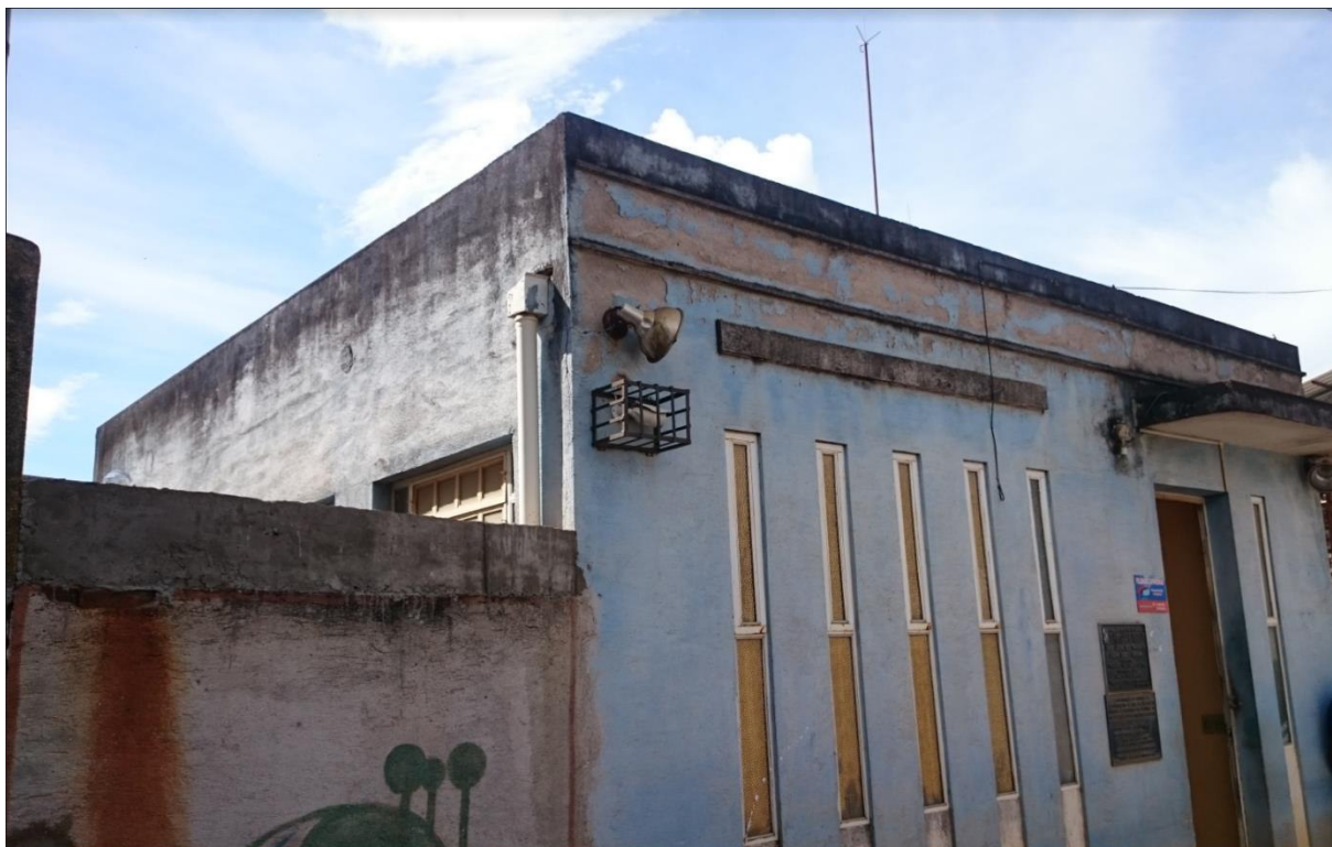
Figura 21 - Estação elevatória São José do Triunfo.
