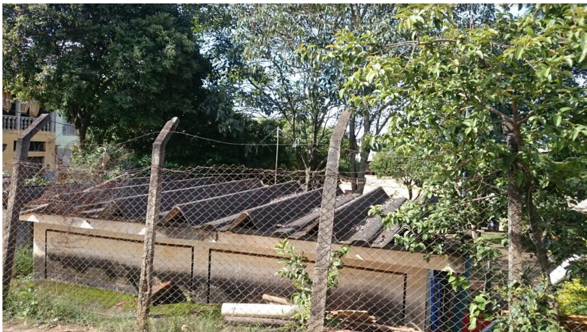
Figura 28 - Casa de máquinas do Booster Nova Viçosa; vista do telhado.
