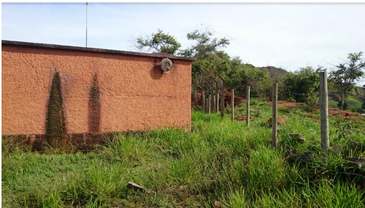
Figura 23 - Reservatório Nova Viçosa
