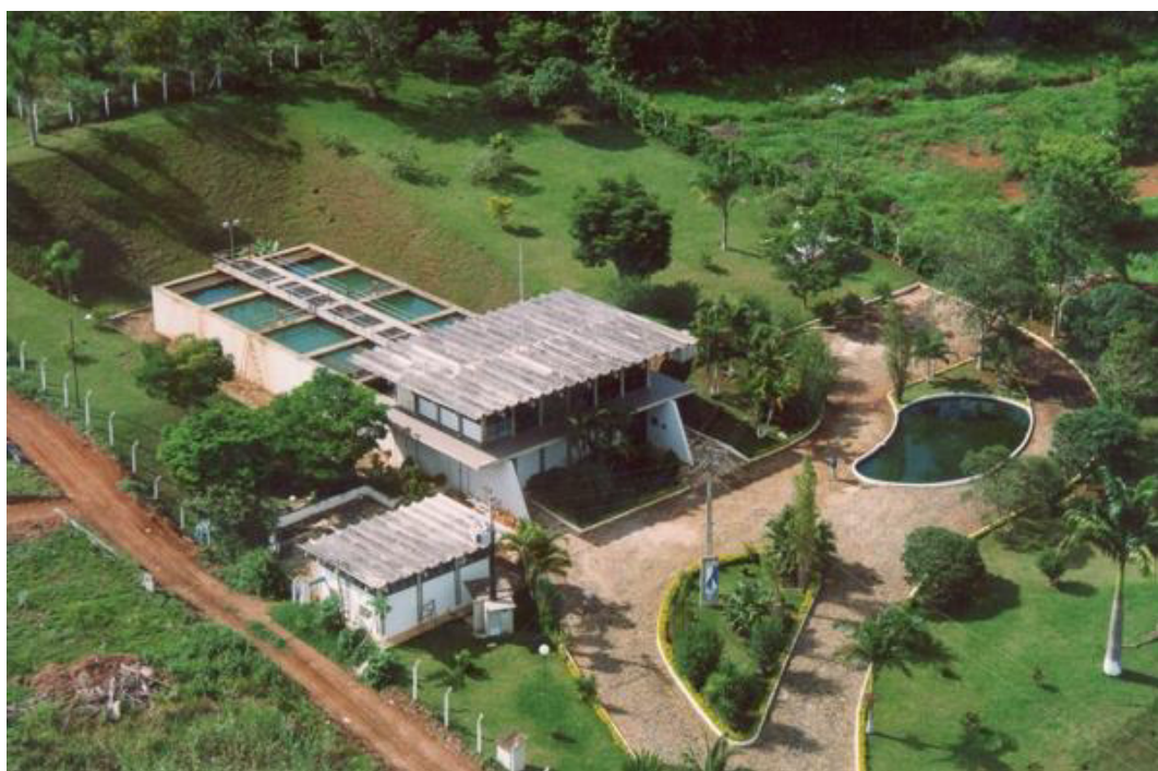
Figura 7 - ETA 2: Uma das estações de grande consumo do SAAE. Conta com área abundante e subestação própria conectada à rede de distribuição local (13,8kV).(SAAE, 2016)
