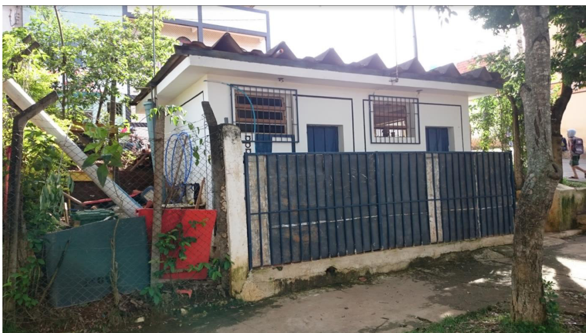
Figura 27 - Casa de máquinas do Booster Nova Viçosa.
