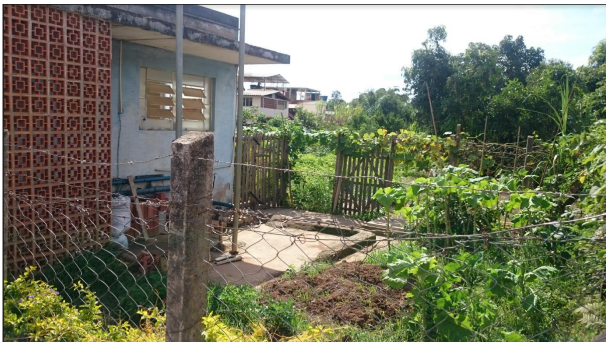
Figura 22 - Terreno da estação elevatória São José do Triunfo
